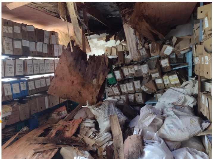
Almoxarifado central com infiltração, teto deteriorado, água parada, sem organização
